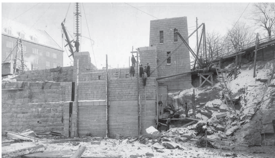
Grästensmurning av östra landfästet och maskinhuset i januari 1915
