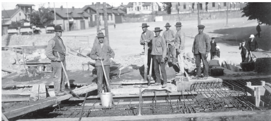
Gjutningsarbeten för klaffbronns östra landfäste i juli 1915
