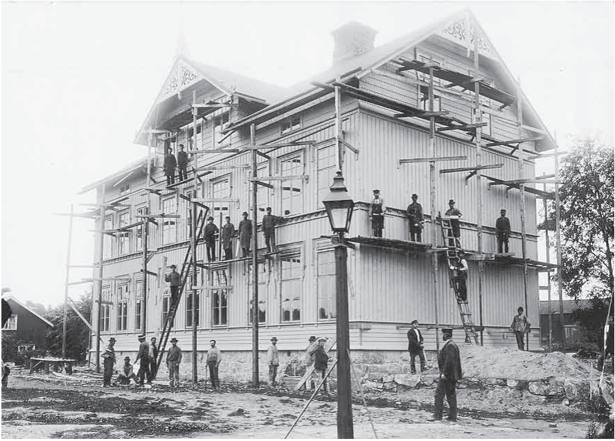
Gamla samskolan under byggnad.
