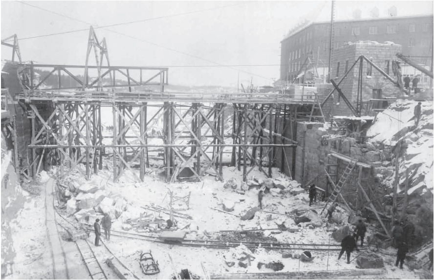
Monteringsarbetet har börjat i mars 1915
