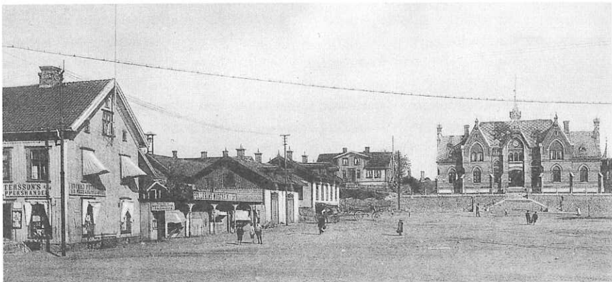
Edw. Petterssons Bok & Pappershandel, Basarerna, Grand hotels stallbyggnader, sedermera Trollhättans brandstation, "slottet" och tingshuset vid Karl Johans torg.
