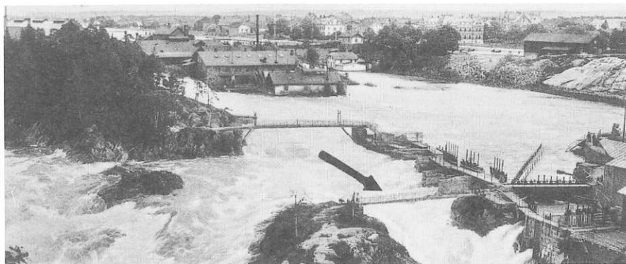
Toppöbron (vid pilen).
