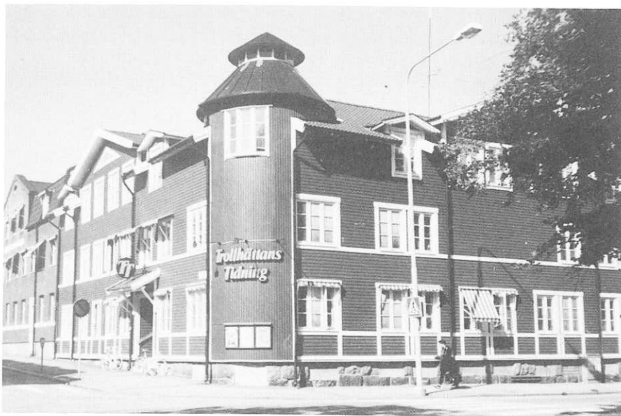
I kvarteret Rödjan ligger Trollhättans Tidnings nuvarande lokaler. De äldre byggnaderna på Stavereds-gatan är bevarade och mycket pietetsfullt restaurerade.
