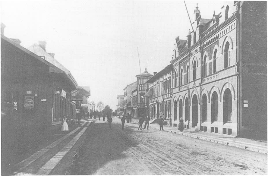
Huset t.v. inrynde från 1867 Björklunds apotek. T.h. syns det av apotekare Leth byggda apotekshuset.
