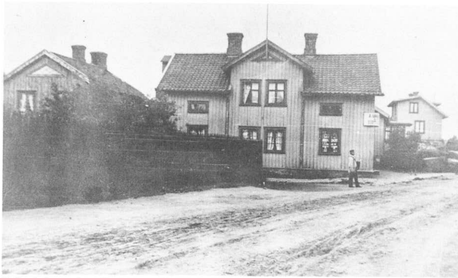
Välkända byggnader på Storgatans nordligaste del nämligen Wilhelm Carlssons affär, Oscar Sahlbergs veranda och Emil Dahlmans hus.
