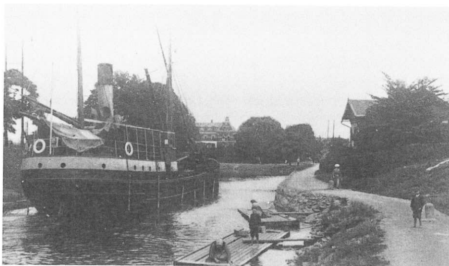
Sköljflotten i kanalen söder om Kanalverkets byggnad.
