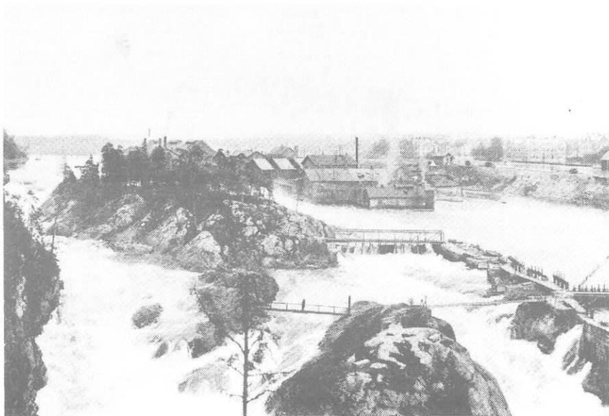
Gullö och Toppöarna samt Gullöfors Bruk vid sekelskiftet.
