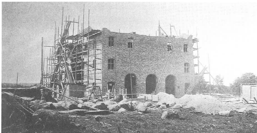
Ugnshuset under byggnad den 4 juni 1910, sett från öster.
